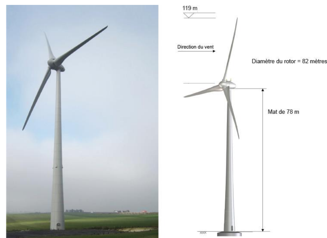
Figure 62 Représentation du type d'éolienne retenue : la ENERCON E-82 2.3 MW sur mat de 78 m
