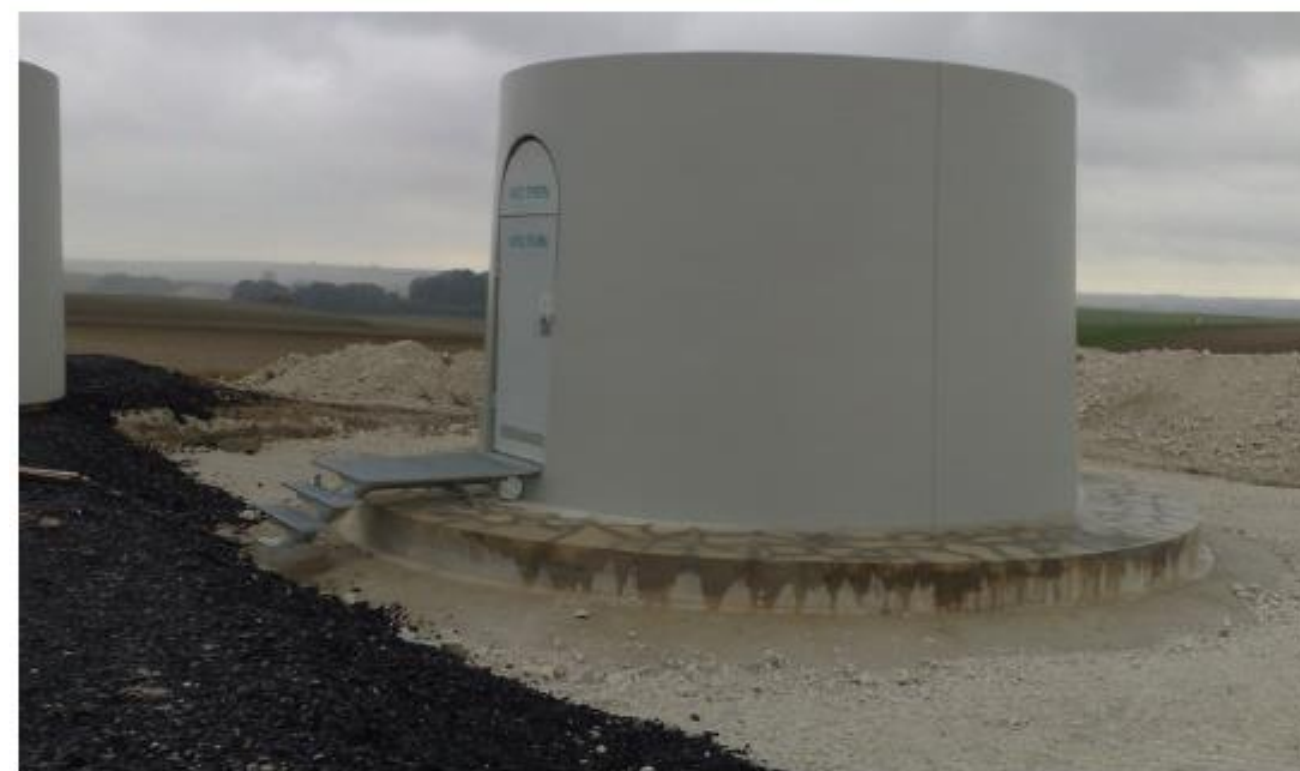
Photographie 70 Gestion des fondations
