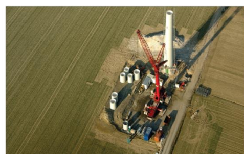
Gestion du chantier
